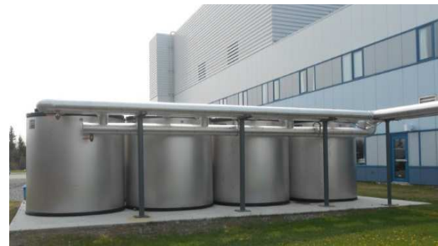
Remplacement du système de refroidissement
